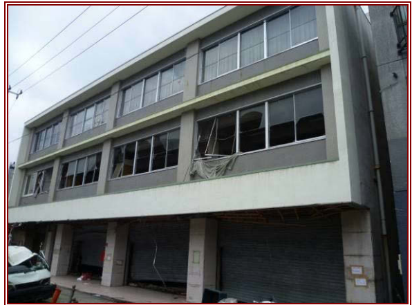
(d) RC shear wall, D2, 5 m inundation.
