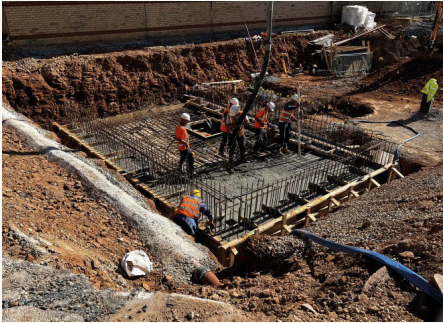
↓FIGURE 3: Watertight concrete pour in progress
